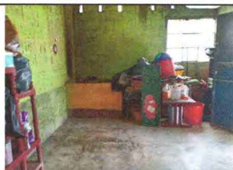
FOTOGRAFIA 6. SE PROPONE SUSTITUCION DE ESTUFA, ISLA DESAYUNADOR Y COLOCACION DE PILA
